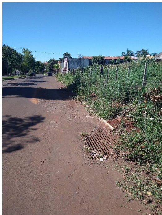
Figura 06 – Caixa de coleta pluvial em frente ao lote na Av. Venâncio Aires
